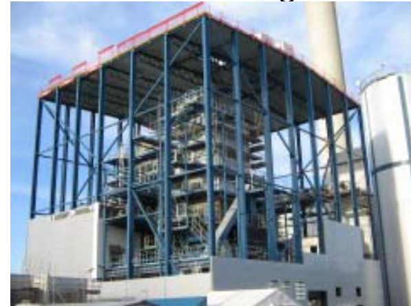
Stor rost fuktig flis
