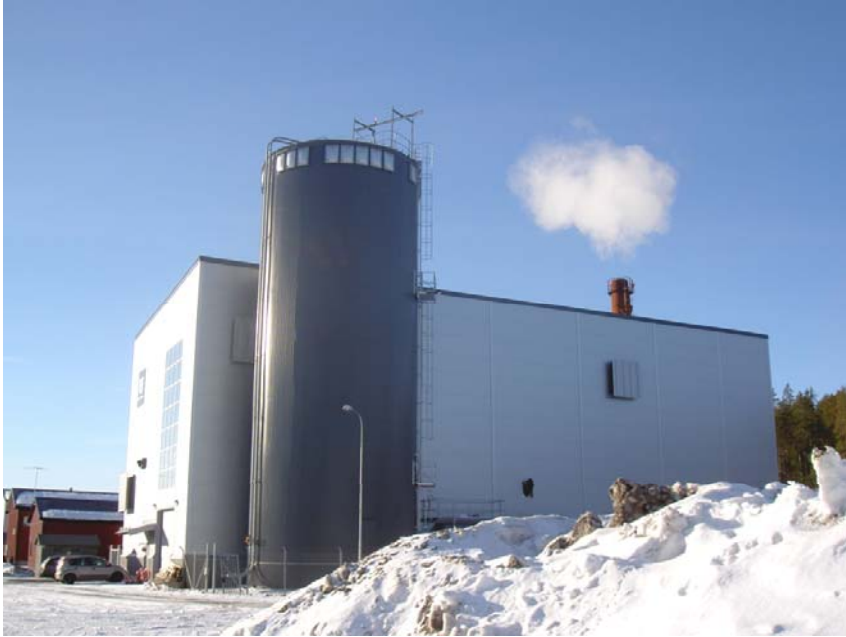
Röbäck 25 MW pulvereldad (2st cyklonbrännare) hetvattencentral i Umeå
