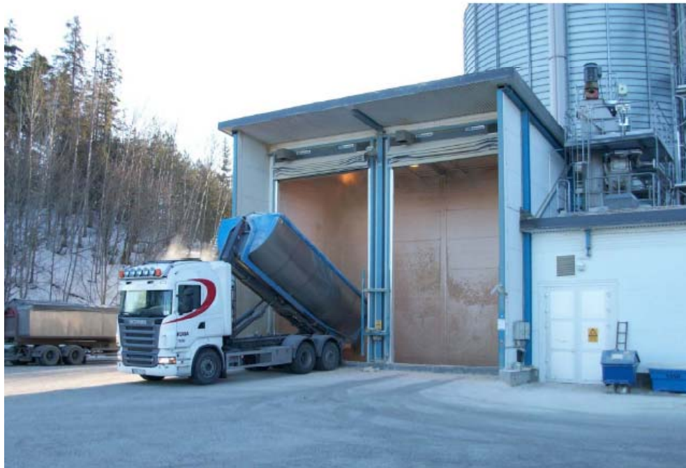
Söderenergi Fittja 130 MW (TPS Termiska Processer AB)
